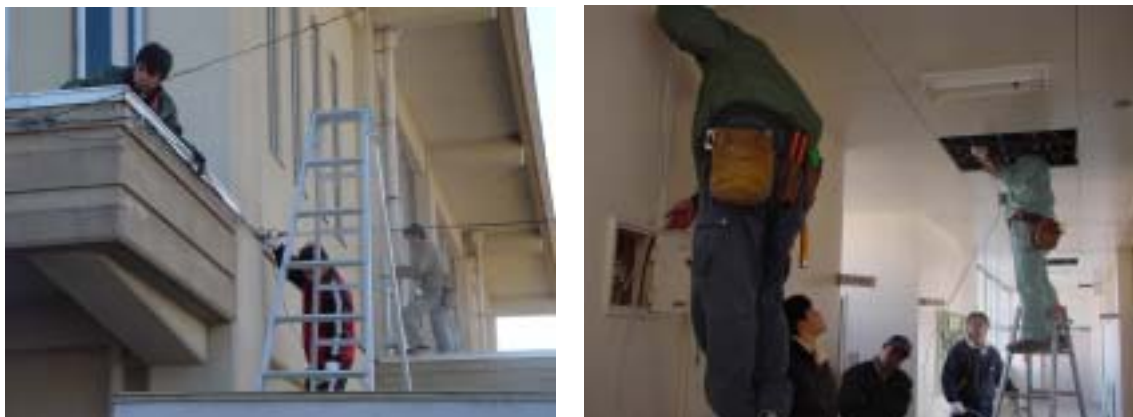
図 A-8 事前工事における配線工事風景 図 A-9
